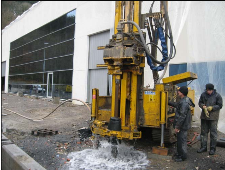
Perforación geotérmica en Industrias Galarza S. A.
