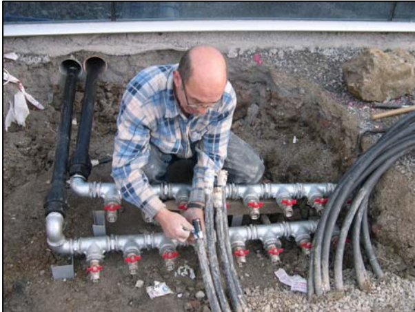
Conexión Colectores
