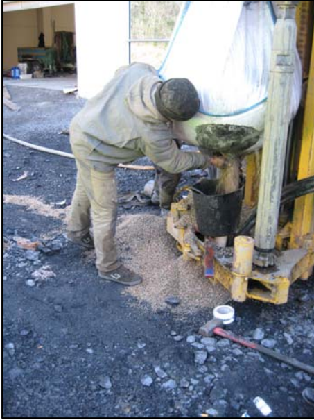
Relleno con grava de sílice
